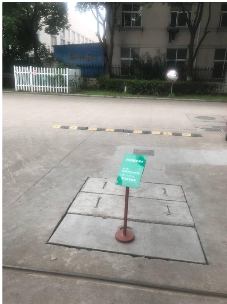
图4-1 污水排放监测井
