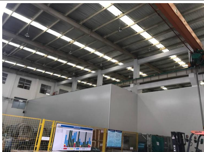
冲压车间隔音墙1
