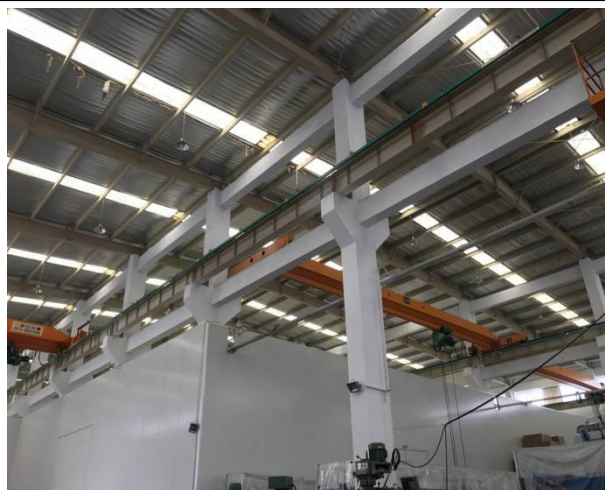
冲压车间隔音墙2
